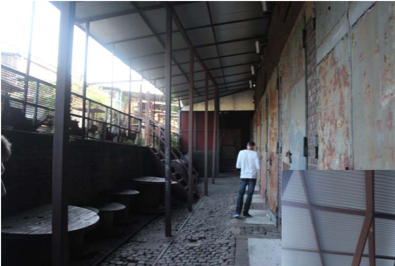
Übergang vom Gracejones zum Trafo (Überdacht)
